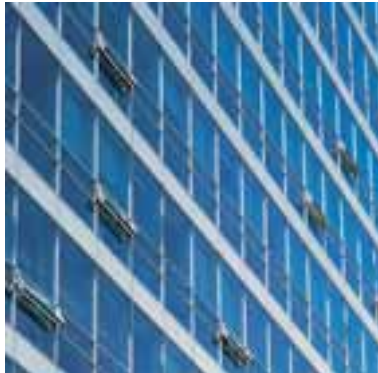
Strabag Zentrale, Wien, Österreich Strabag Head Office Vienna, Austria
